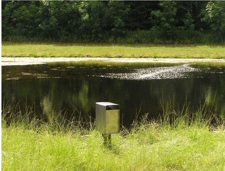
Iltning af sø med lavtrykskompressor og bobleslange
